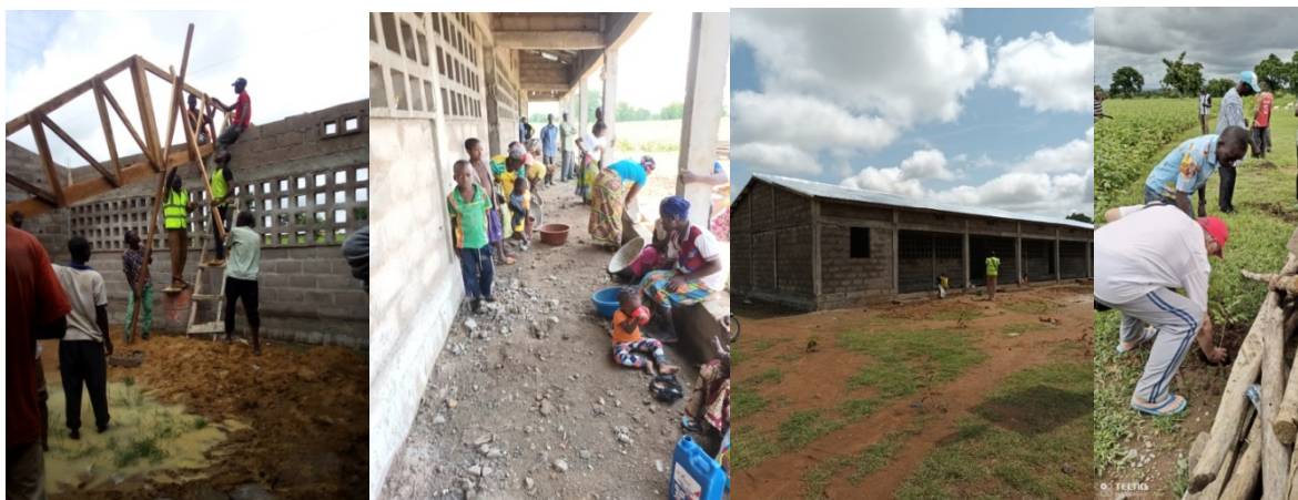
Fotos de proceso de la obra
